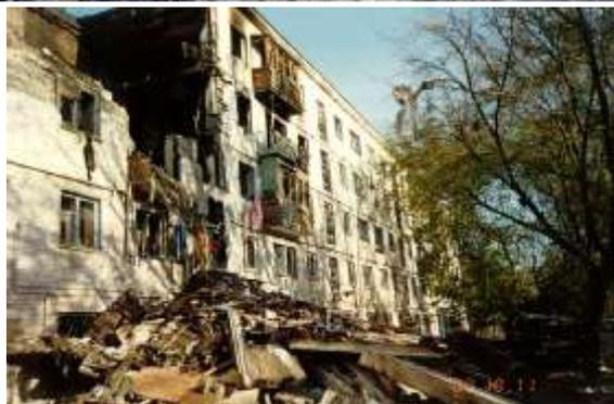
Рисунок 1.1.18 - Примеры типичных разрушений жилых домов, вызванных аварийными взрывами
