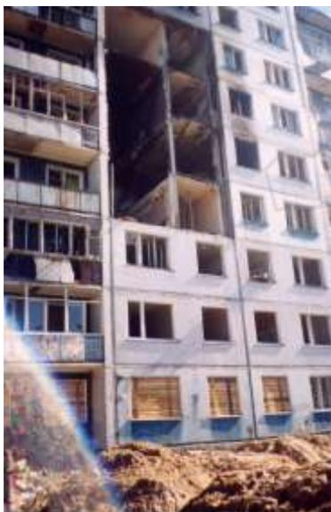
Рисунок 1.1.14 - Последствия аварийного взрыва
